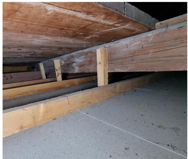
Abb. 3.1.5 Verbindung Balkenlage-Sparren Foto RB
